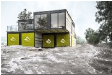
Ces mêmes jumelés sont protégés de l'inondation par les panneaux étanches développés par Thinking Habitat. fournie par Thinking Habitat
